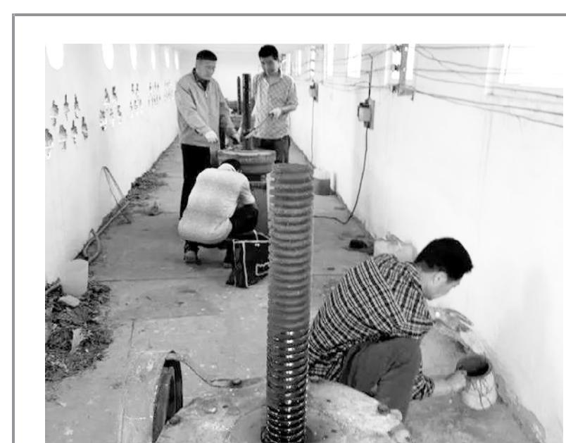
近日,扶沟县召开防汛抗旱工作会议,部署相关工作。会后,县水利局管所干部职工紧急行动起来,对全县所有大中型节制闸进行擦拭保养,为安全度汛奠定了基础。图为工作人员保养节制闸。记者 朱东一 摄
