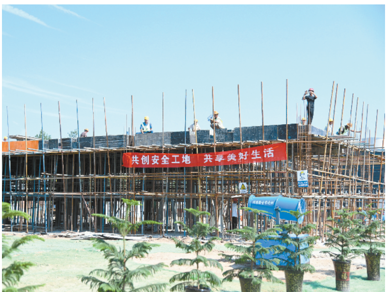
河南亨科京建科技有限公司新型防水卷材项目建设稳步推进。 记者 王映 摄
