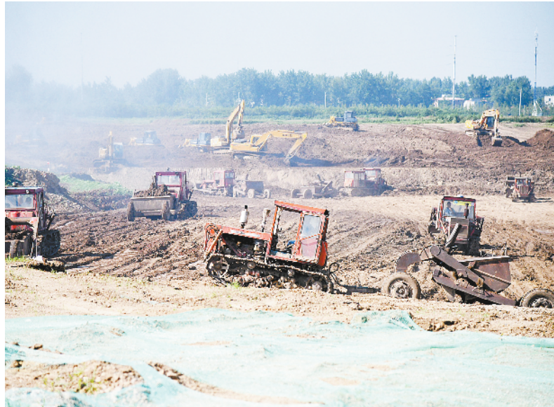
项城市内河综合整治工程——如意湖项目建设掀起高潮。 记者 王映 摄
