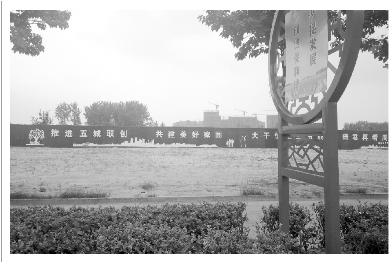
连日来,我市各施工单位按照市委、市政府统一部署,在施工现场外树起高标准绿色环保围挡,有效降低了施工扬尘,营造了和谐美丽的城市环境。图为七一路东段一处公益宣传围挡。
