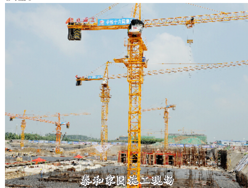
泰和家园施工现场
