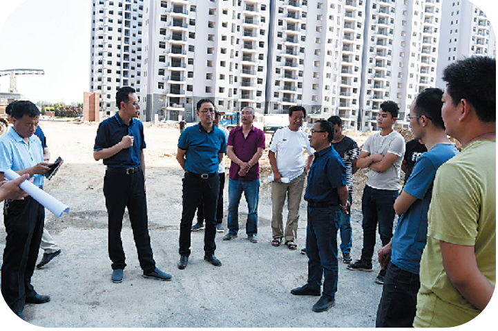
开发区管委会主任王文峰到棚户区改造安置区小学及幼儿园项目工地现场办公
