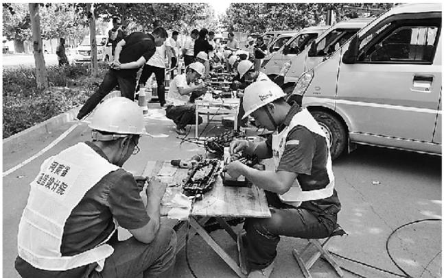
6月18日上午,周口联通公司为了检验各级维护人员应急能力,提高突发事件处理响应速度,紧密结合汛期通信保障工作要求和汛期应急预案可执行性,联合省设计院、省工程局代维单位,在经济开发区富民路,对各县(市)代维单位临时下发演练指令,组织开展全专业网络应急演练。120余人次、30辆车参加本次演练。图为现场光纤接续。
