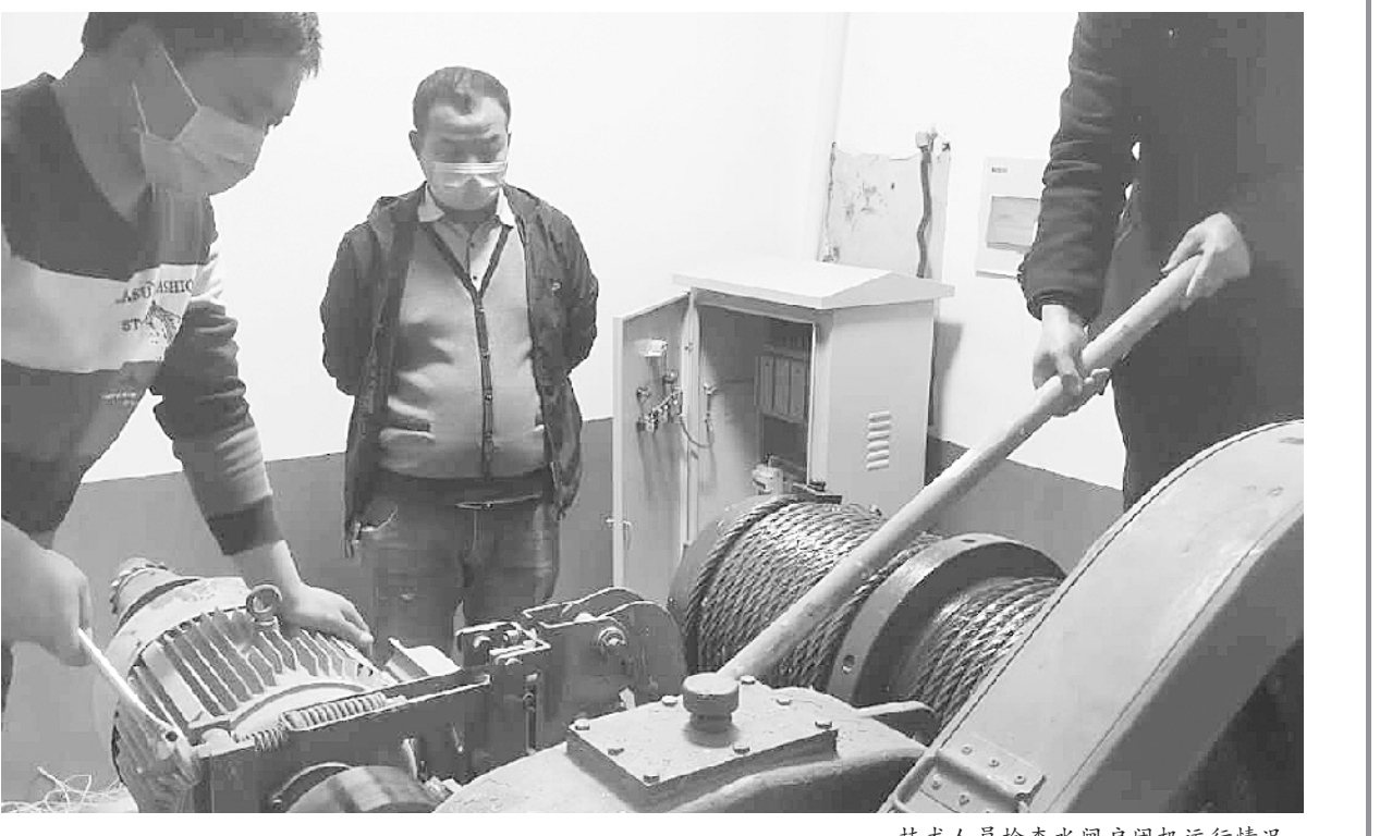
技术人员检查水闸启闭机运行情况。
