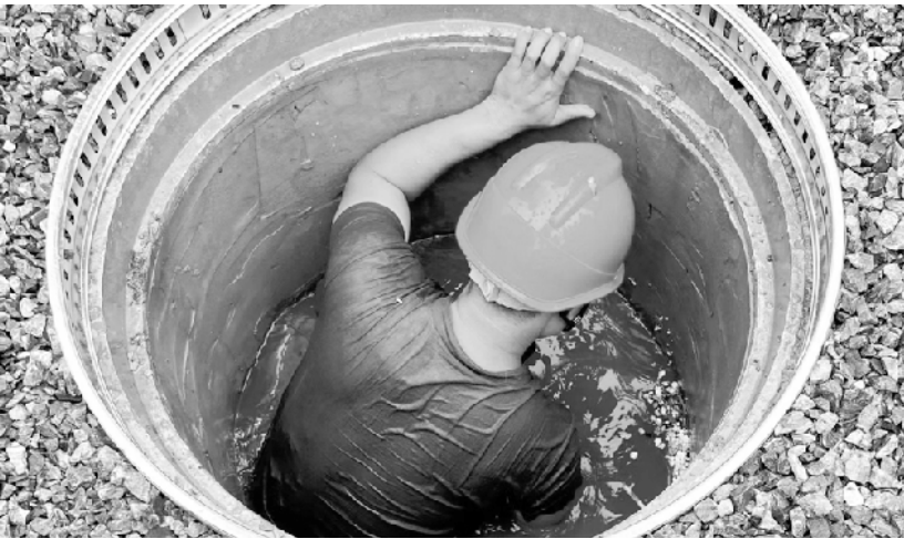
抢修人员跳入深井对排水口进行封堵。
