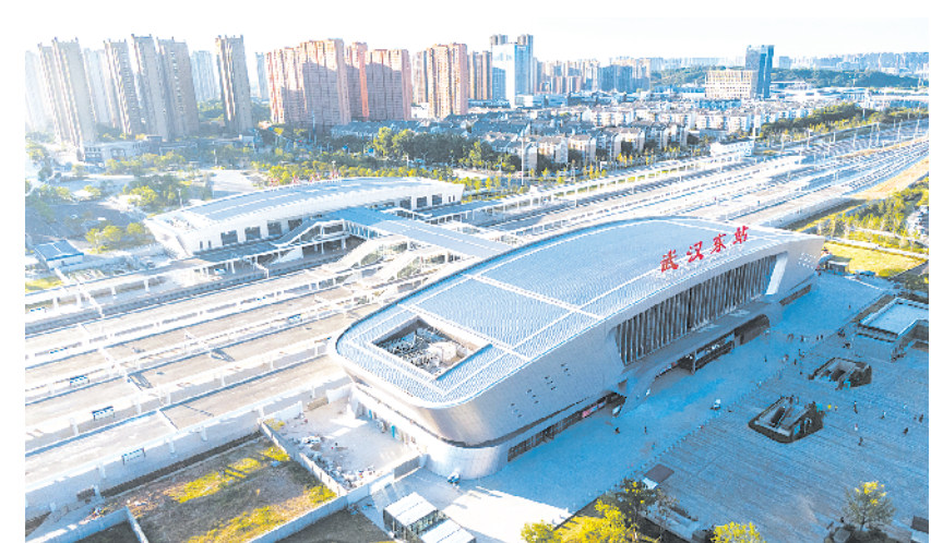
武汉开通第四座大型铁路客运站
