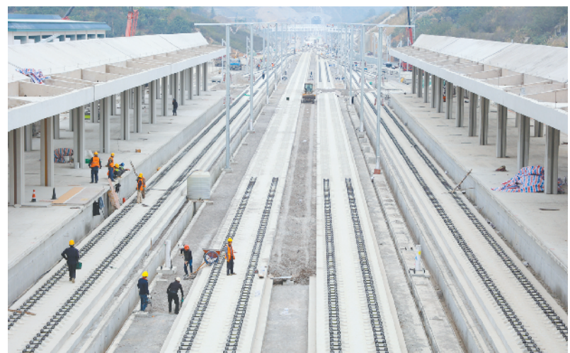
贵南高铁贵州荔波站主体封顶
