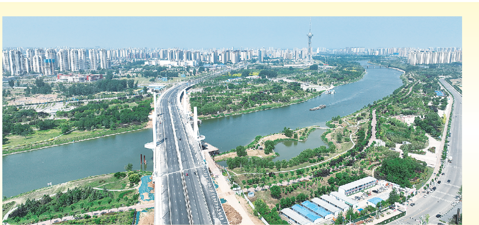
市城乡一体化示范区作为全市城乡一体化发展先行区,从“一片地”绘就“一张图”,再根据高标准规划蓝图建起“一座城”,实现了从无到有、从蓝图到实景的蝶变,正在拔节生长、蓬勃发展。图为七一路跨沙河大桥俯瞰图。
