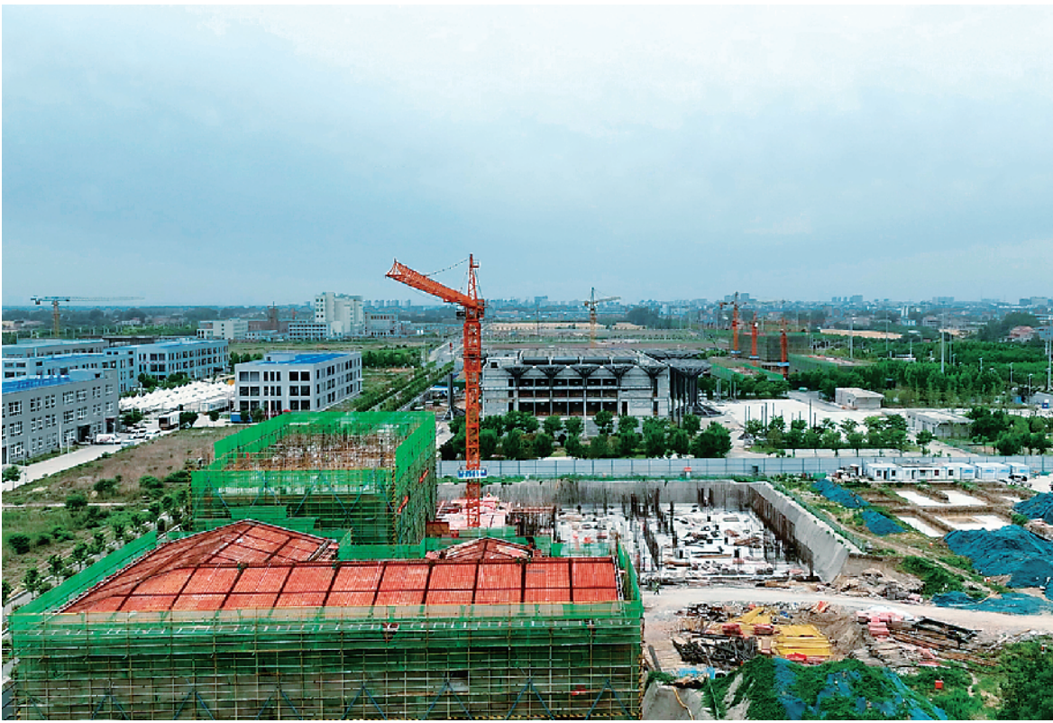
重点项目建设现场。记者徐松摄
