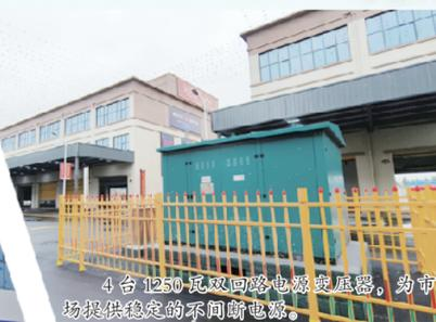
4台1250瓦双回路电源变压器,为市场提供稳定的不间断电源。
