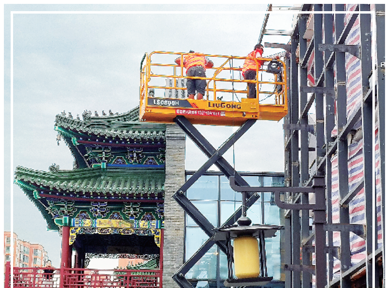
9月5日,两名工人在周口中心城区关帝庙历史街区茶街外侧墙体焊接构件,进行修缮提升。近年来,川汇区对关帝庙历史街区精细管理,丰富街区业态,提升街区品质,进一步打造了消费新场景。记者 沈湛 摄
