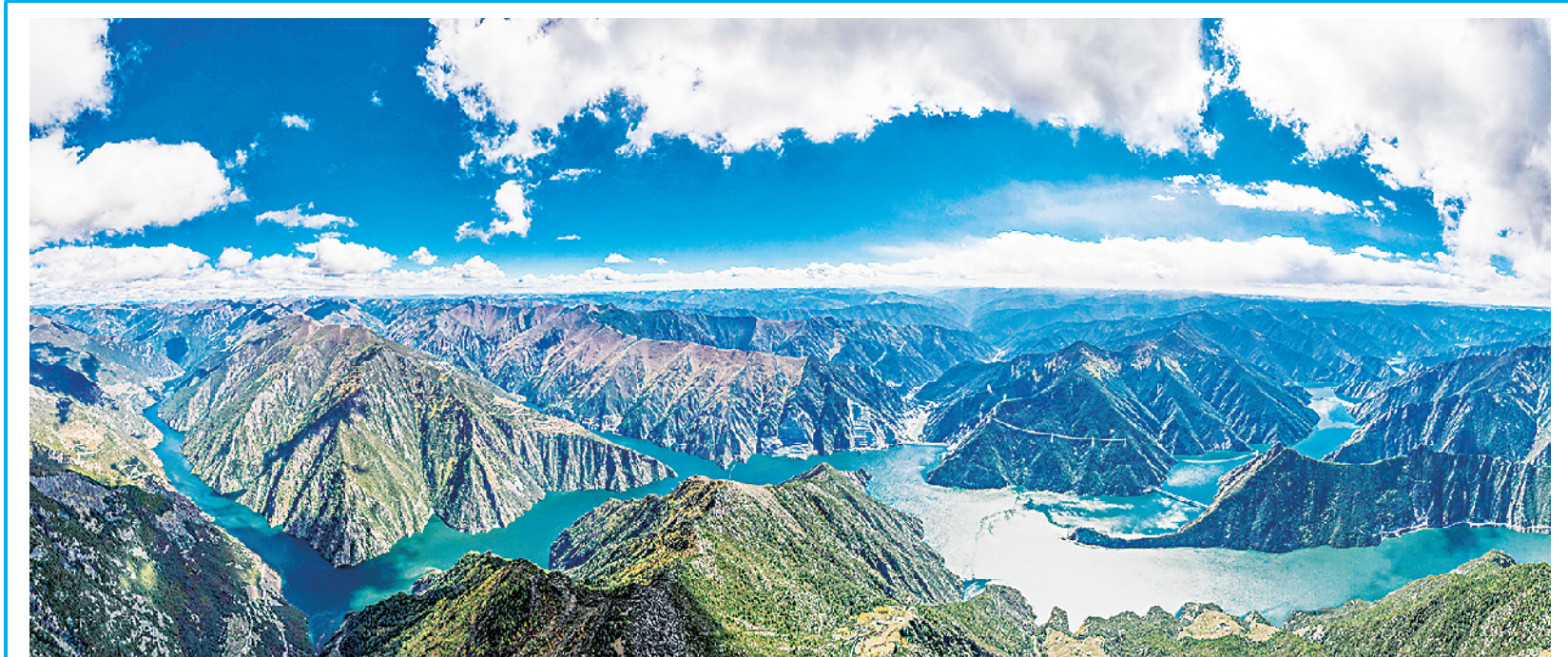
雅砻江两河口水库全景(10月25日摄,无人机照片)。10月25日,我国海拔最高的百万千瓦级水电站——两河口水电站蓄至正常蓄水位2865米。这标志着我国第三大水电基地雅砻江的中游龙头水电站首次满蓄,对增强今冬明春四川电力保供能力,提升雅砻江梯级电站发电、防洪等综合效益具有重要意义。 新华社发
