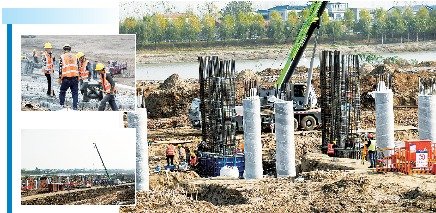
周口港中心港区中心作业区是全省“两河两港”建设的重大项目，也是周口打造国家内河航运重要枢纽的强劲支撑。目前，退建大堤、码头桩基以及配套工程等正在加紧建设中。 记者 王映 摄
