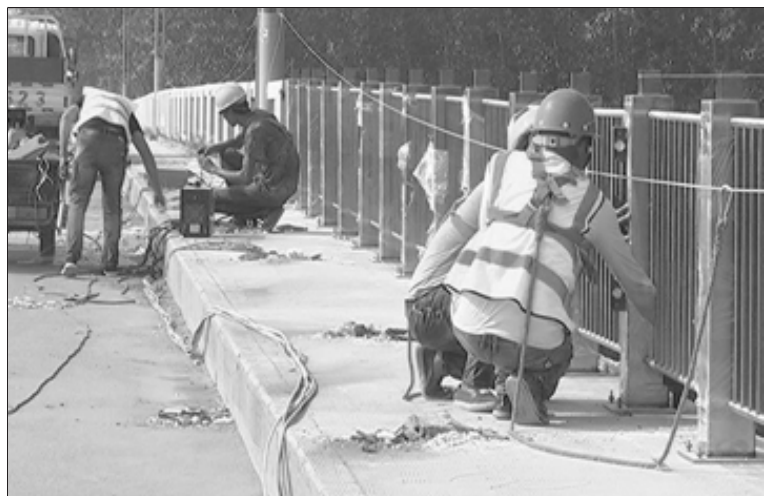
周口大道沙颍河桥施工现场
