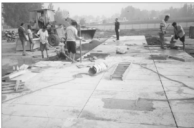
纪念广场正在加紧施工
