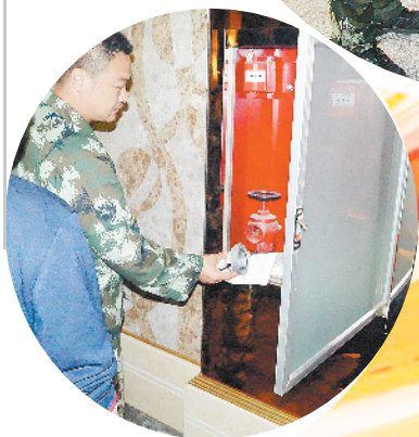
检查消防设施
