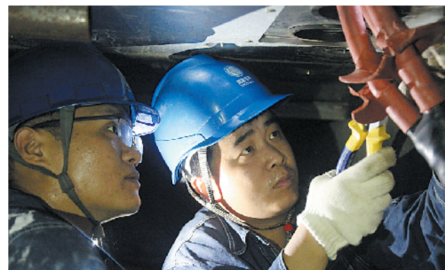
检修人员检修，确保可靠供电。
