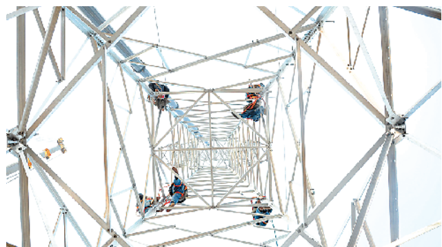
对杆塔进行迁移，助力城市建设。
