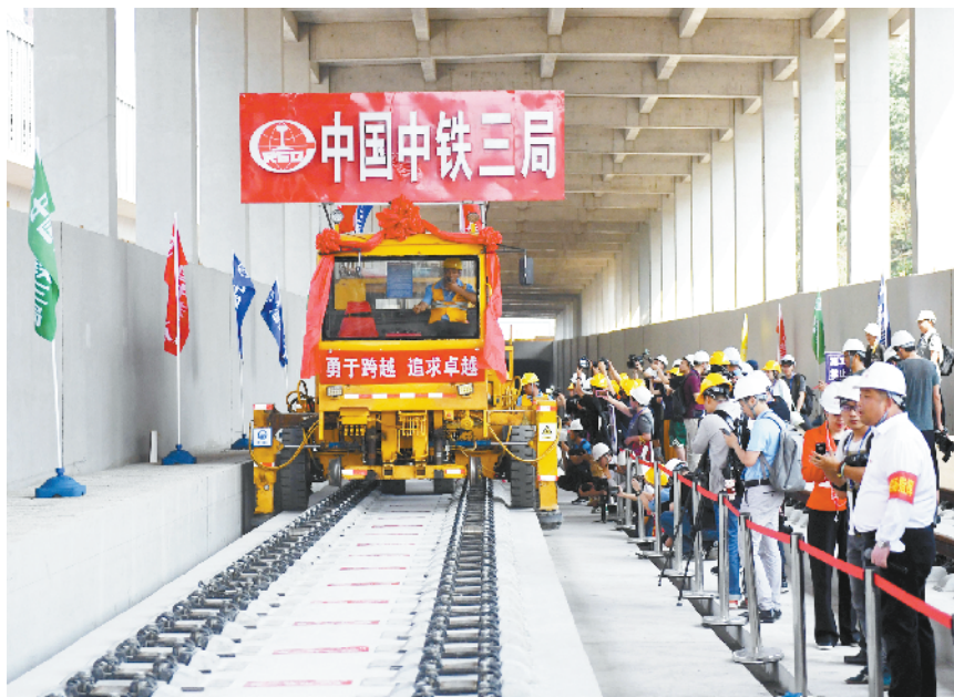
6月12日,铺轨机在京张高铁清华园隧道进行铺轨作业。
