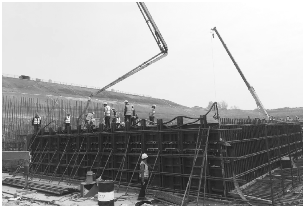
首块底板混凝土开始浇筑
