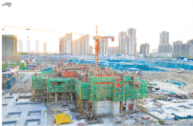
一峰·梦想城施工现场
