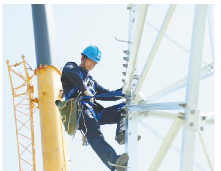
4月25日，在商水县姚集乡朱庄村附近的麦地里，国网周口供电公司的施工人员正在紧张组装110千伏线路铁塔，为110千伏白寺变电站顺利投运奠定基础。
