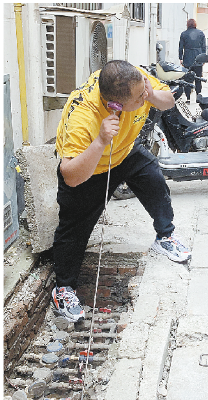
听漏工利用专业工具查找漏水点
