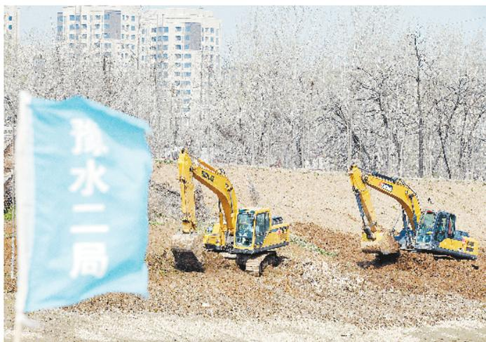
3月24日上午，多部挖掘机正在川汇区贾鲁河段开展堤岸加固加宽工程。今年年初开始，贾鲁河综合治理项目总投资73.97亿，长度148公里。贾鲁河周口段将近85公里，涉及扶沟县、西华县和川汇区三个县区。目前，河道清淤、堤岸加宽加固工程正在进行中。③2
