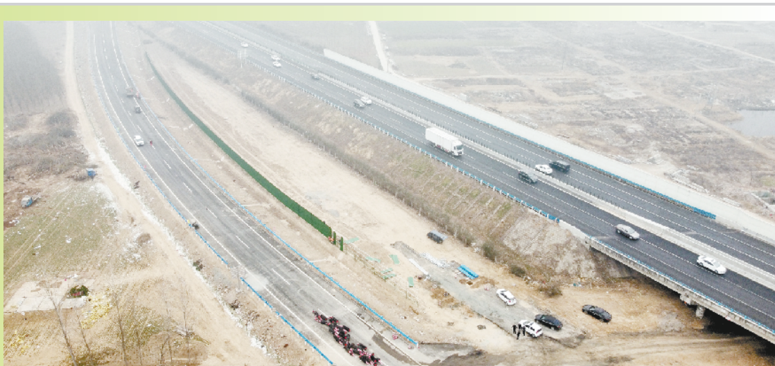
2月8日,平安大道东延项目大广高速临时辅路铺设完成,正在进行道路安全设施施工,验收合格达到通车要求后,平安大道东延下穿大广高速工程即可开展施工。S324线淮阳G106至大广高速改建工程是我市“一中心两组团”市域快速通道项目的一个重要环节,该项目位于市城乡一体化示范区和淮阳区境内,是连接这两个区域的重要交通设施,对完善城市功能、提速中心城区一体化发展具有重要意义。②2 记者 刘俊涛 摄
