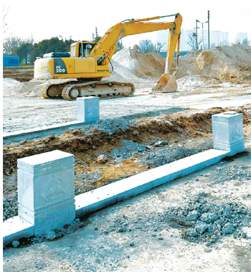
建设大道东延项目施工现场。
