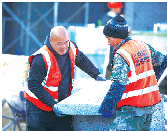
工人正在搬运地砖。
