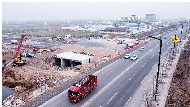
平安大道东延项目一处桥梁工程即将完工。
