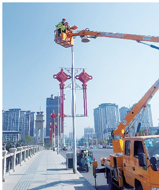
市政工作人员头顶烈日维修路灯。
