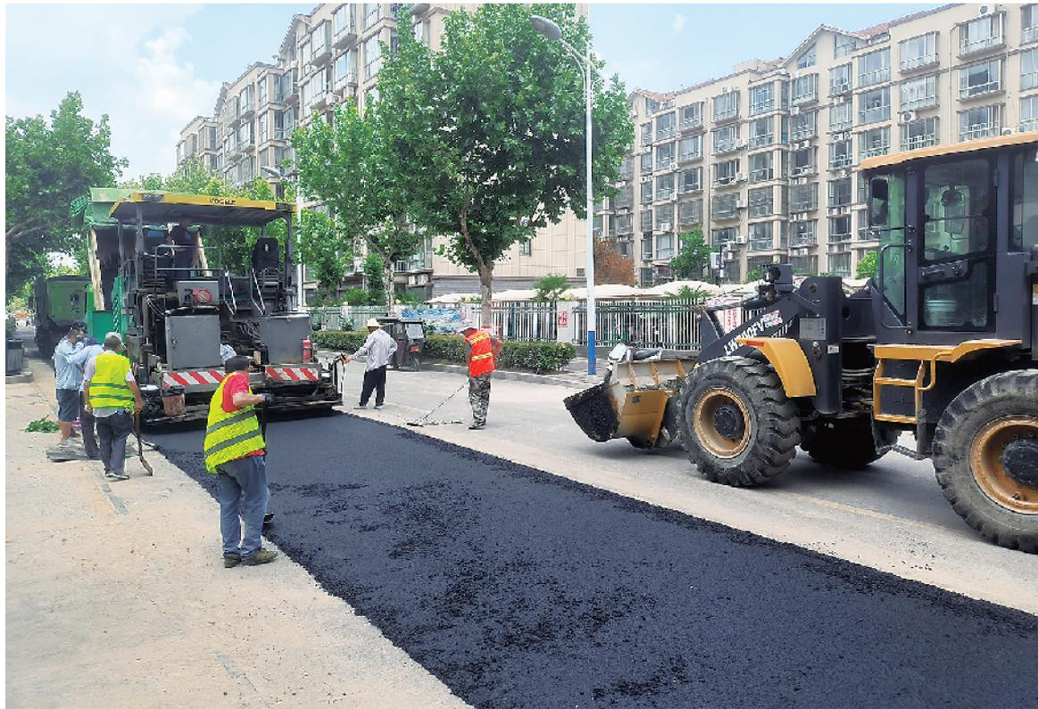
5月25日，中心城区府汇街（中原路至周口大道段）雨水管网改造工程接近尾声，进入路面铺设阶段。据了解，中心城区部分道路存在排水系统老化等问题，市政部门对部分路段及时进行提升改造，方便市民生活和雨季出行。
