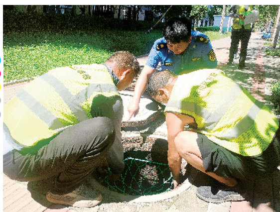
工作人员在安装窨井防坠网。
