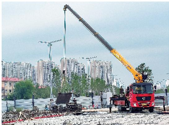
9月2日,中心城区建设大道洼冲沟桥加宽工程正紧张施工。目前,洼冲沟桥主桥预制桥面板全部安装完成,标志着项目主梁施工完成,正式进入桥面施工阶段。
