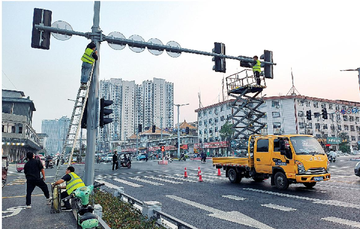
日前，随着中州大道（沙颍河桥至建设大道段）改造升级，中州大道与文昌大道交叉口相关配套交通指示牌正在安装中。据了解，此处交通指示牌安装后，对文昌大道西延路段开通做好了交通秩序管理准备。
