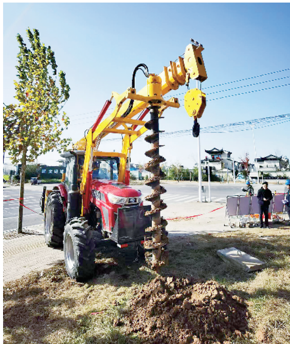
打孔立杆架线一体机正在进行钻孔作业。
