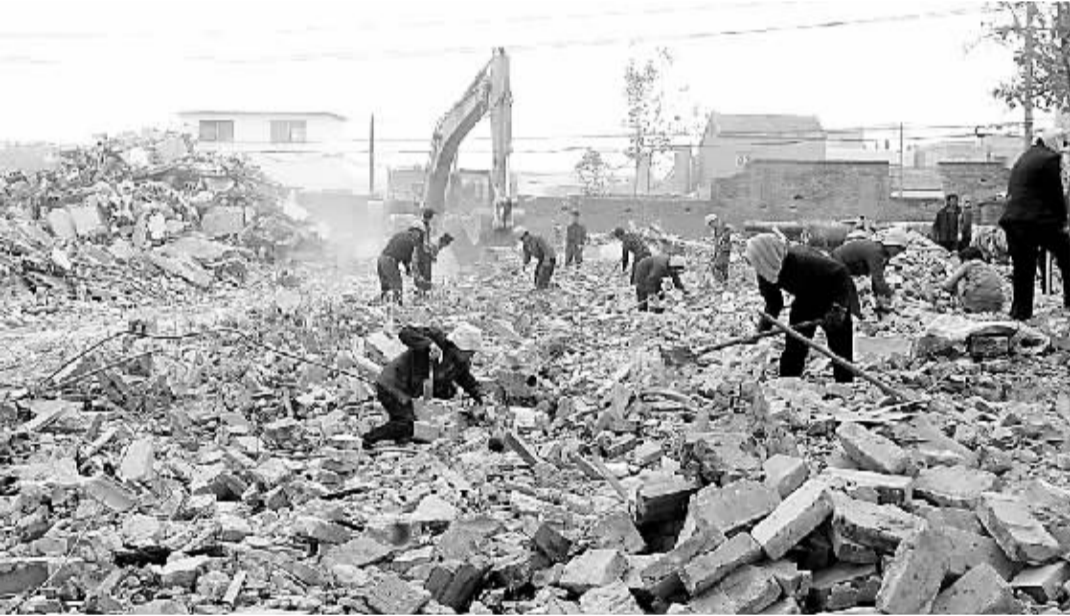
10月29日,工人正在拆除鸡鼓凤机器有限公司的厂房。作为文昌大道拆迁安置小区建设用地之一,该公司加快了老厂区的设备、厂房拆除步伐。(李寒 理效明 摄)
