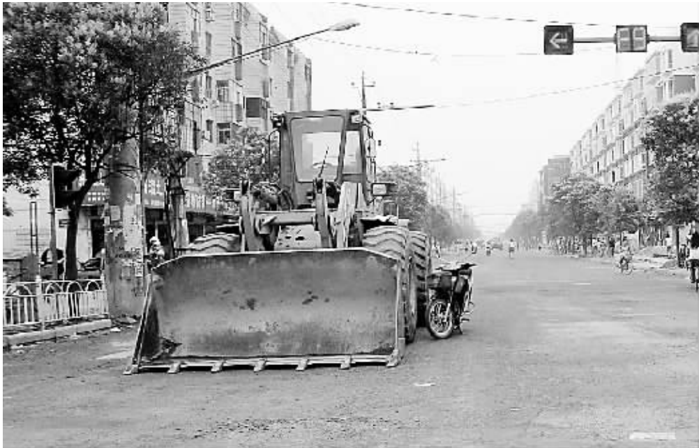
6 月 18 日,东大街道路整修施工现场。为切实解决群众行路难问题,日前,项城市对城区多条道路动工整修,深受广大市民赞扬。记者 张猛 摄
