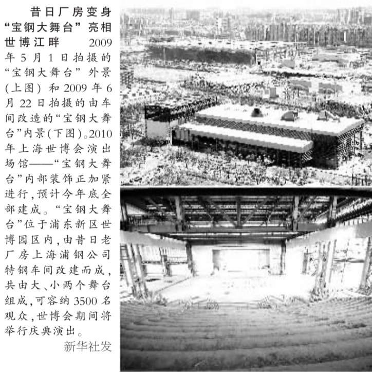
昔日厂房变身“宝钢大舞台”亮相世博江畔 2009年5月1日拍摄的“宝钢大舞台”外景(上图)和2009年6月22日拍摄的由车间改造的“宝钢大舞台”内景(下图)。2010年上海世博会演出场馆——“宝钢大舞台”内部装饰正加紧进行,预计今年年底全部建成。“宝钢大舞台”位于浦东新区世博园区内,由昔日老厂房上海浦钢公司特钢车间改建而成,共由大、小两个舞台组成,可容纳3500名观众,世博会期间将举行庆典演出。
