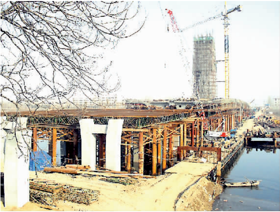
连日来的严寒丝毫阻挡不了建设者的工作热情,大庆路桥建设工地上处处是火热的工作场面。市区建设路贯鲁河大桥的正式通车,极大地鼓舞了这里的桥梁建设者。他们一致表示,一定会保质保量地把大庆路桥如期交给周口的广大群众。(记者 沈湛 摄)
