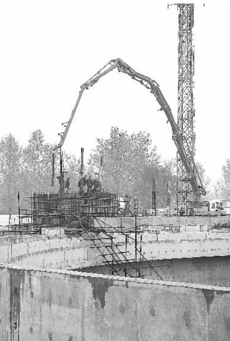
正在施工中的沙南污水处理厂二期工程。 记者 李寒 摄
