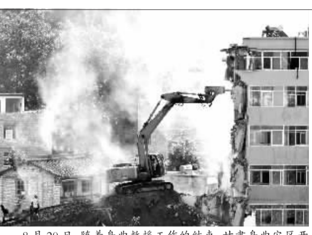
8月20日,随着舟曲救援工作的结束,甘肃舟曲灾区开始动用大型工程机械,拆除因山洪泥石流造成的危房,为复建做准备。 新华社记者 刘彬 摄
