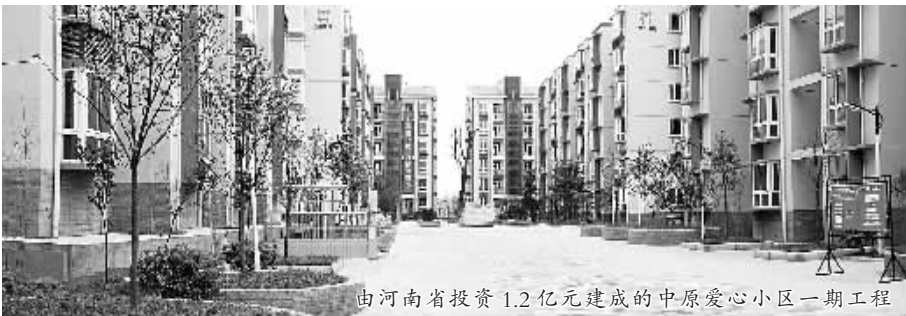
由河南省投资 1.2 亿元建成的中原爱心小区一期工程
