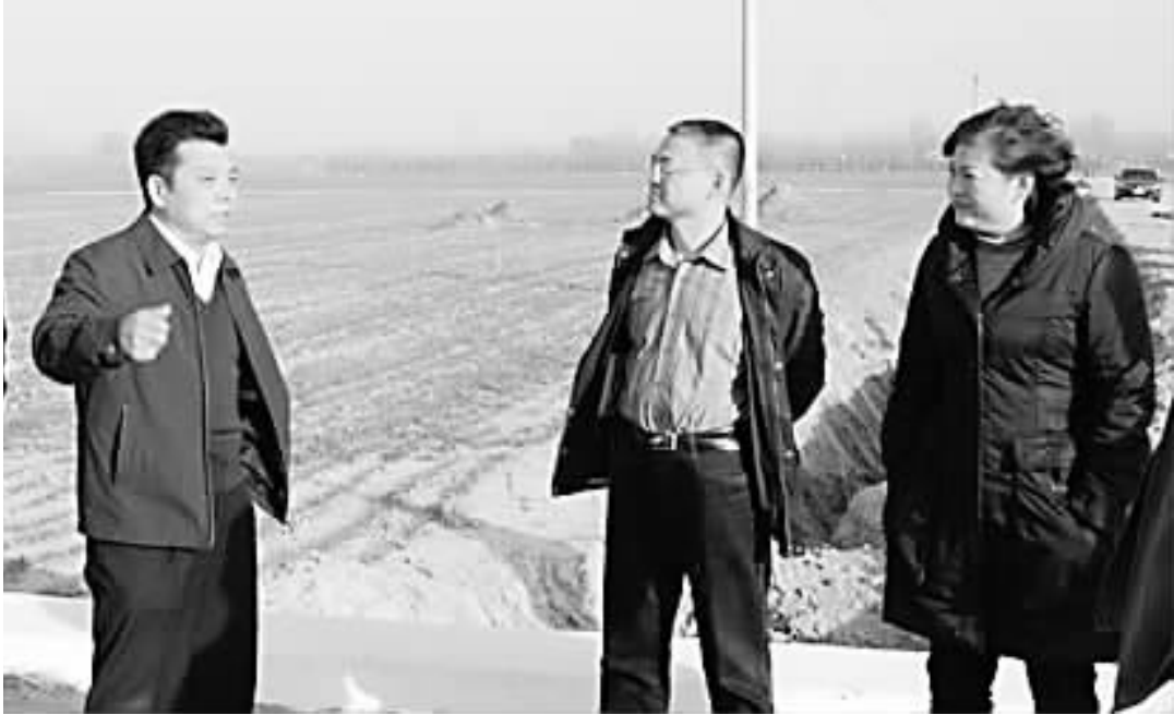
县委书记任连军在白楼镇黎庄村农业综合开发项目施工现场实地察看工程建设情况。(闫俊岭摄)
