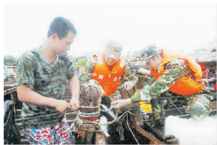
8 月 8 日,大堤边防支队官兵和渔民一起加固堤坝。当日,台风“梅花”逼近辽宁。为确保渔民和游客生命安全,大堤边防支队的官兵在海岸加强巡逻,并登上渔船进行巡查。(新华社发)
