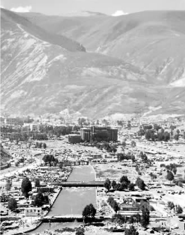
图为结古镇局部(8月10日报)。根据青海省玉树地震灾后重建工作领导小组的安排,2011年玉树重建将投入资金200亿元,拟安排项目798项,涵盖城乡居民住房、基础设施、公共服务设施、和谐家园、特色产业、生态环境、征地拆迁等7个方面。截至7月底,玉树灾后重建已累计开工建设413个项目,年内将力争完成全部重建项目规划设计和农村住房重建,完成大部分城镇住房重建,开工建设大部分公共服务设施和基础设施项目,形成150亿元的实物量。新华社发
