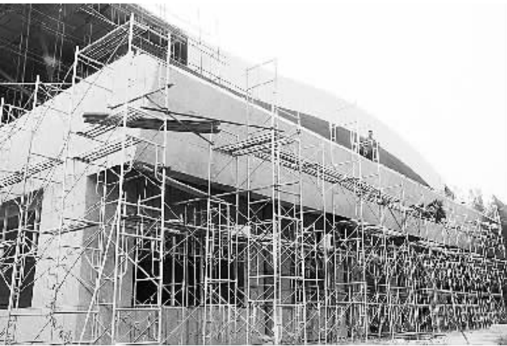
近年来,项城市坚持以人为本,紧抓民生建设不放松,努力营造良好的人居环境,受到市民一致好评。图为正在施工中的项城市体育馆。(赵献伟 摄)
