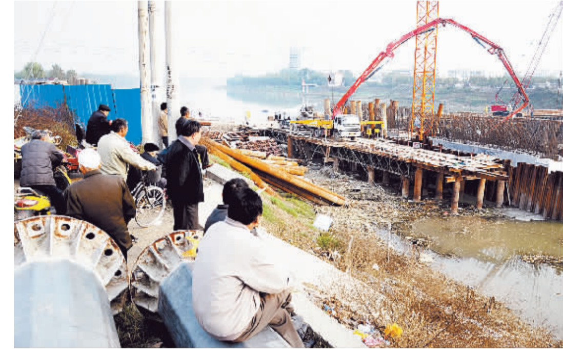
昨日,一群市民关注市区八一路桥梁建设进展。新建桥为连续梁结构桥,桥长190米,桥宽40米。(记者 沈湛 摄)
