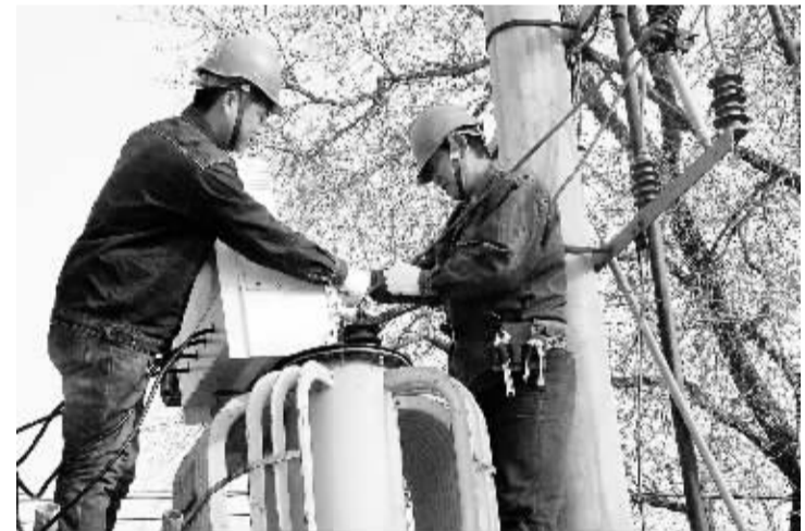
项城市供电公司有限企业对全县1445台配电变压器进行普查,全面消除台区线路接点氧化、线径细等供电隐患,确保冬季用电高峰可靠供电。图为该公司城郊供电所检修人员在谢村台区更换高压下线。(刘滨 刘军胜 摄)
