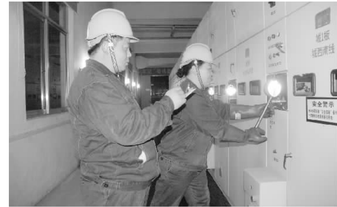
扶县供电公司根据电网负荷变化,科学调整运行方式,加强电压无功和主变经济运行考核力度,确保电网安全可靠、有序、经济运行。图为2月24日,该公司35KV城关变电站运行人员正在进行倒闸操作。(刘滨 刘军胜 摄)
