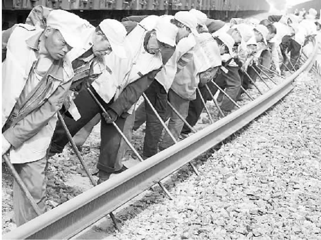
5月1日,在黄(陵)韩(城)侯(马)铁路山运运城河津段,中铁电气化局西铁工程公司的工人们在进行拨轨作业。 本栏文图均据新华社电
